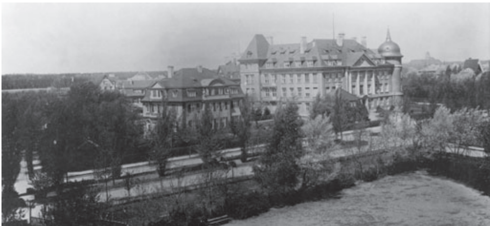
Abb. 11-3: KWI für Chemie von Südosten. Vorn links das Direktorenwohnhaus, in dem später mehrere Mitarbeiterwohnungen eingerichtet wurden (Lise Meitner wohnte beispielsweise seit Ende der 1920er Jahre hier in einer Wohnung im Erdgeschoss).
