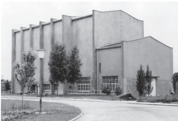
Abb. 11-19b: Das Gebäude für die Hochspannungsanlage.
