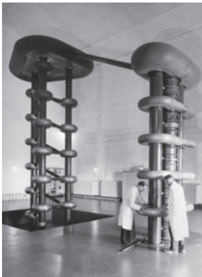
Abb. 11-19: Der für den Minerva-Bau in Berlin geplante und Ende der 1940er Jahre in Mainz aufgebaute Kaskadengenerator für etwa 1,5 MV.
