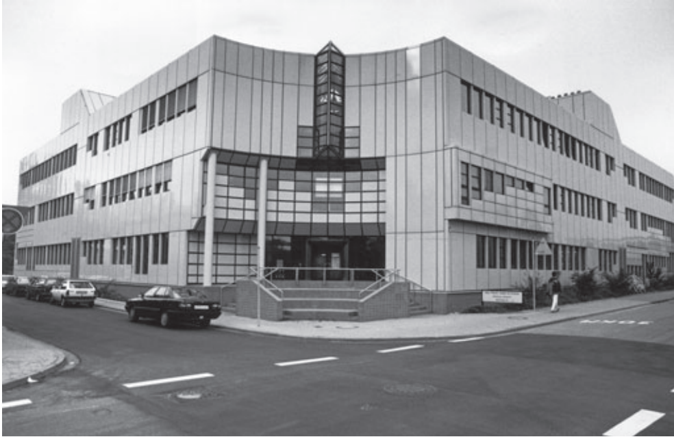
Abb. 11-22: Der Neubau von 1985 für die Abteilung Luftchemie/Chemie der Atmosphäre.
