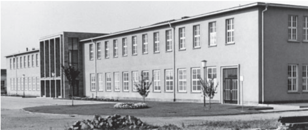
Abb. 11-13: Haupteingang des Institutsgebäudes in Mainz (ehemalige Luftwaffen-Kaserne), um 1953.
