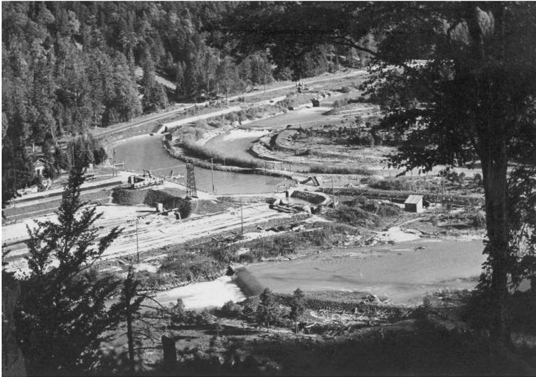
*Abb. 5: Die fertig gestellten Anlagen im Süden des Instituts mit Verteilbecken und Einlauf in die Haltung 1 des Messkanals.*
