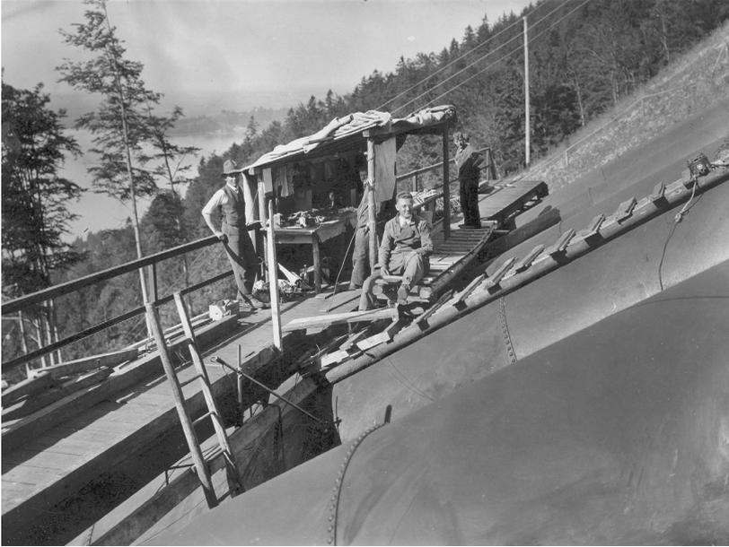
*Abb. 6: Vergleichsmessungen verschiedener Messmethoden an den Druckrohren des Walchenkraftwerks, 1929.*
