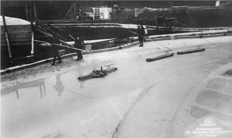
*Abb. 12: Modellversuche über die Steuerfähigkeit von Schiffsmodellen im Bereich einer Kanaleinmündung in die Elbe. Die Schiffe wurden über Lenkstangen gesteuert.*
