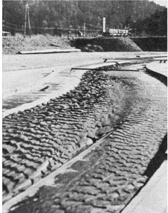
*Abb. 8: Das Hwang Ho-Modell, abgebildet in den 1935 in China veröffentlichten Berichten über die Versuche Engels' in Oberrach.*
